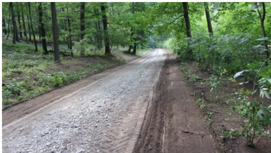
Forstweg mit abgefrästen Banketten, seitliche Auswurfweite: 3m
