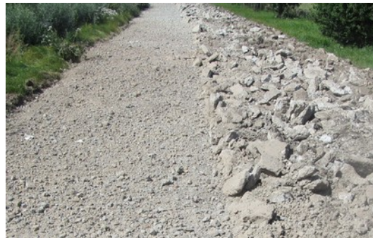
Betonbruch, halbseitig auf 0/45mm gefräst
