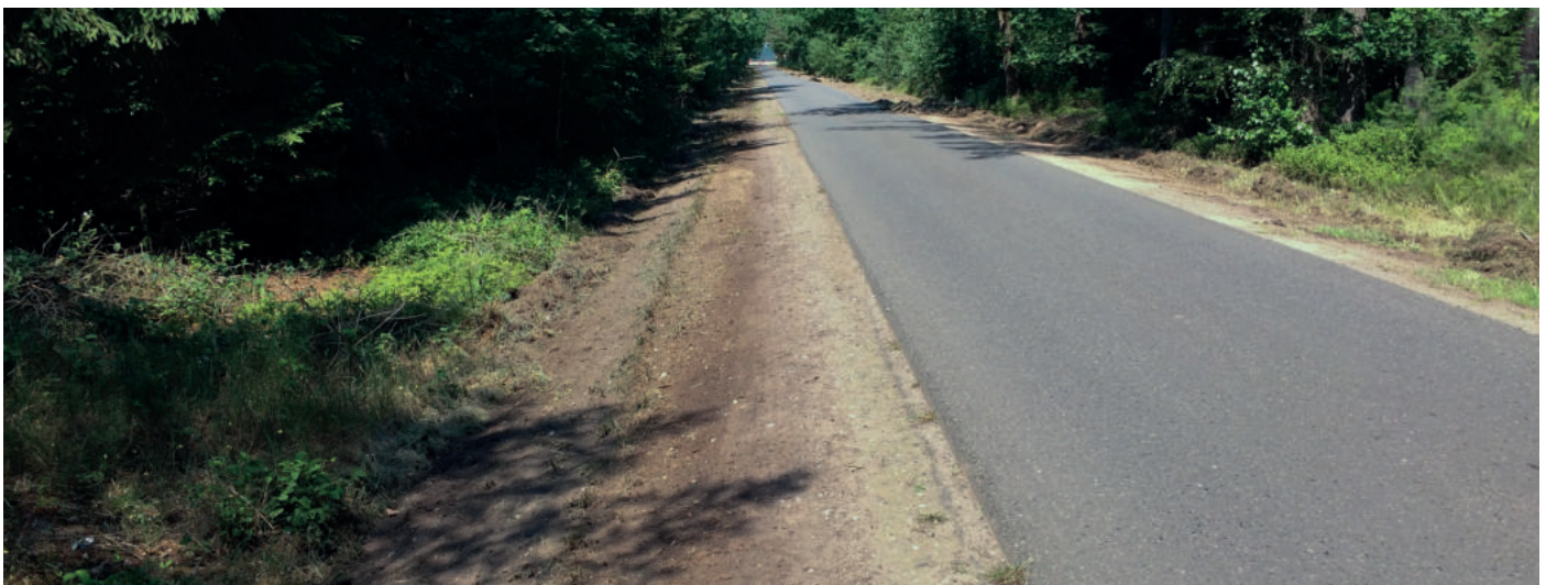
Grundlegende Bankettregulierung, Bewuchs abgeschält, Seitenbankett aufgefärsert und profiliert
