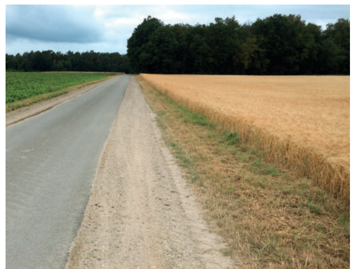
Schlaglochbeseitigung; Bankett durchgefärsert und profilgerecht eingebaut
