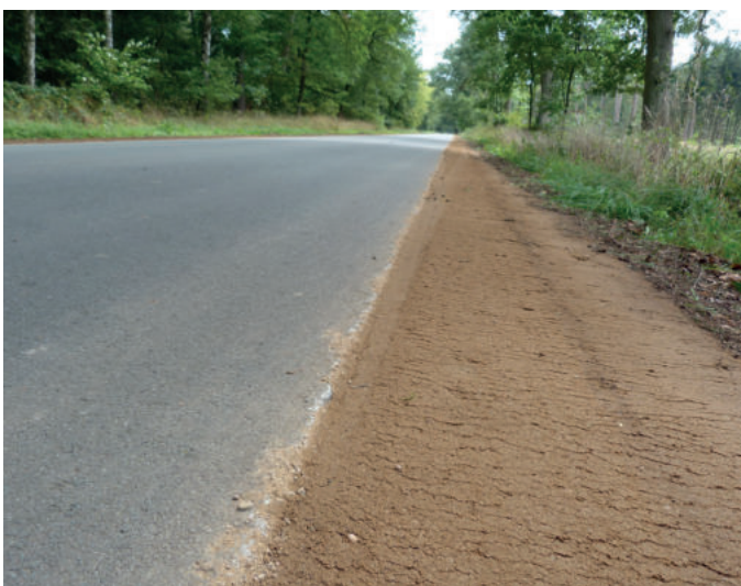
Bankett durchgefärsert und mit zusätzlichem Material profiliert
