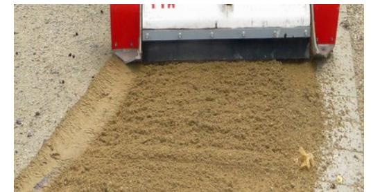
Parkweg mit aufgefräster Deckschicht
